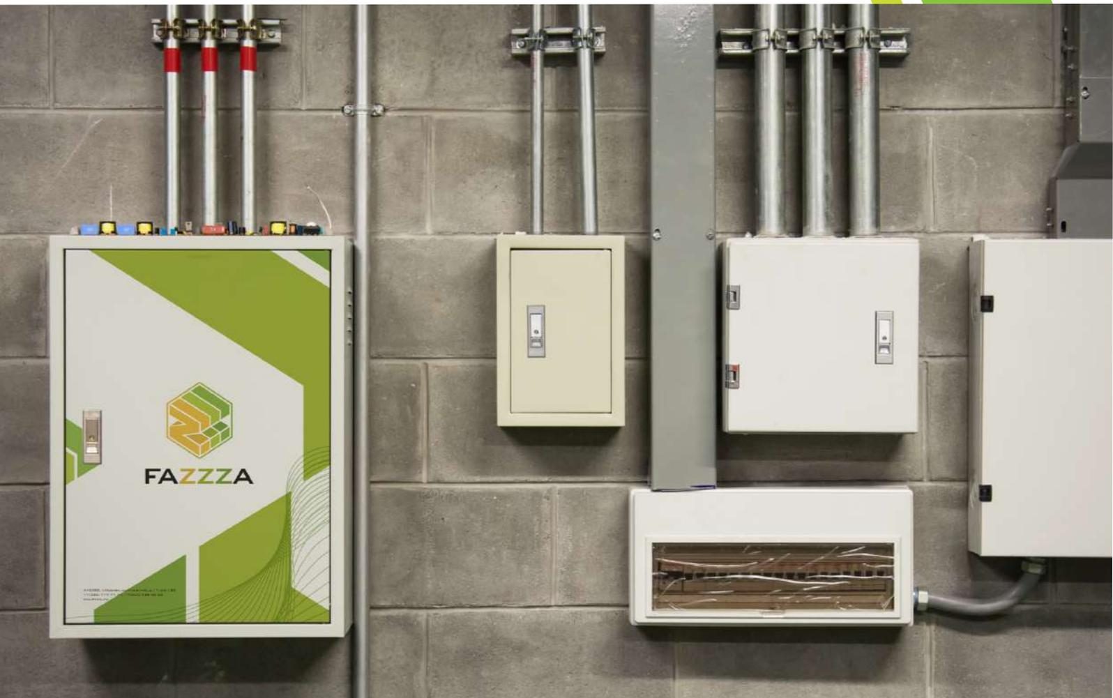
Наше энергоэффективное устройство состоит из двух приборов: технологично усовершенствованный УКРМ, который компенсирует реактивную мощность, и прибор FAZZZA.
